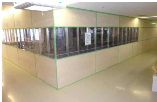
(仮間仕切り設置)
